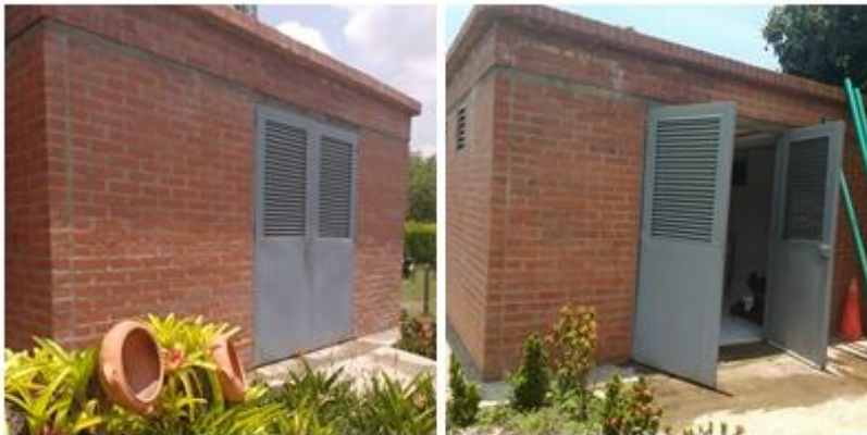
Imagen 14. Centro de acopio de residuos 1
