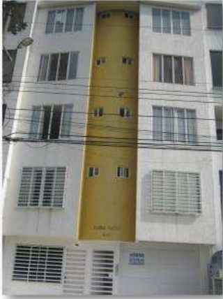
Edificio FLOR DEL PINO Cali
