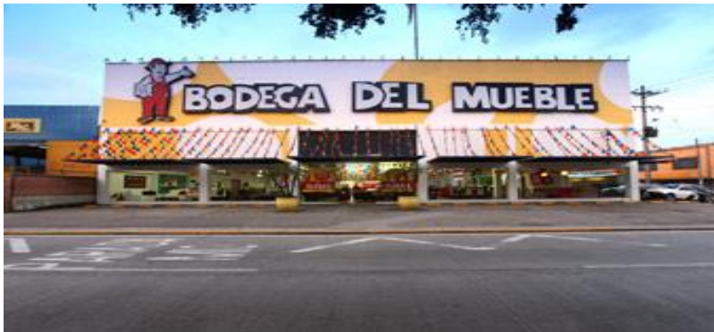
Ilustración 15 Fachada bodega del mueble
