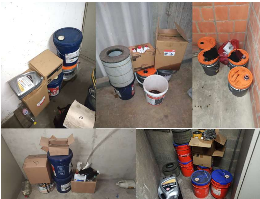
Figura 14 Escenarios de almacenamiento de insumos en zonas de plantas eléctricas
