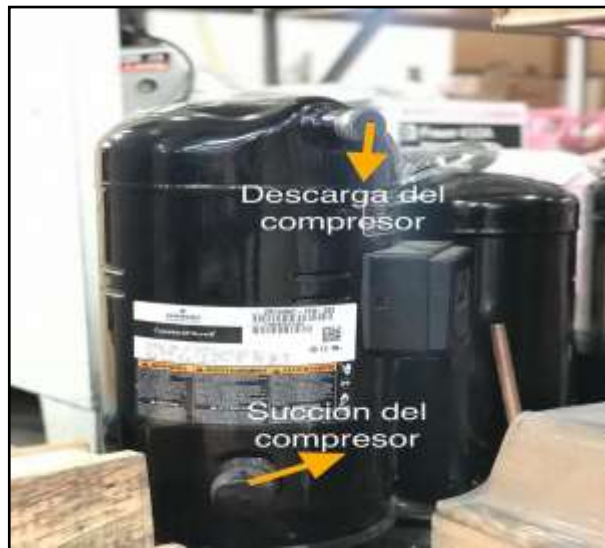
Figura 31 Tuberías del compresor de aire acondicionado de 12TR
