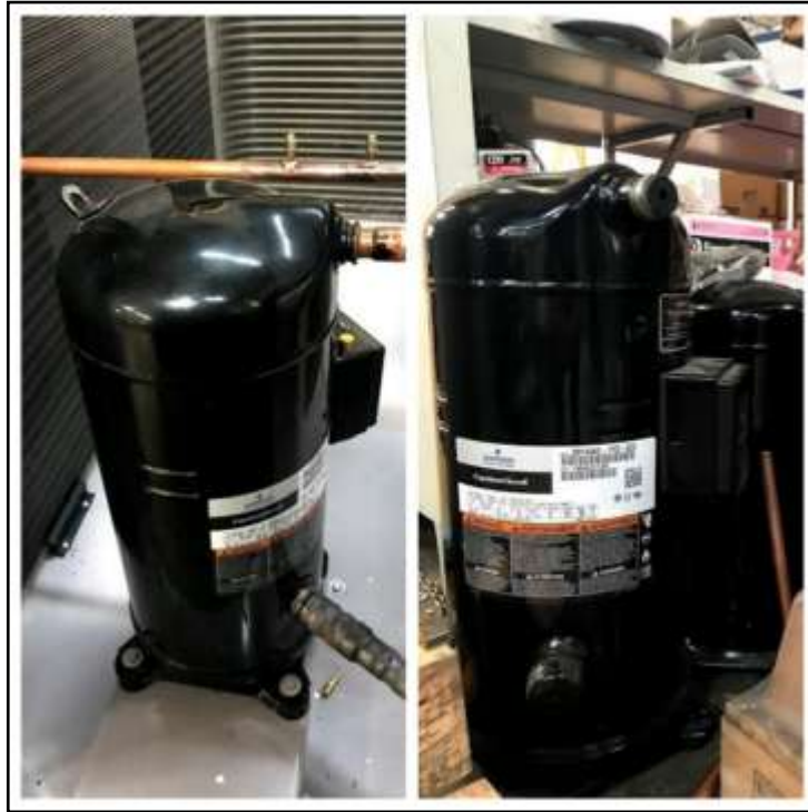
Figura 6 Compresor de equipos de climatización
